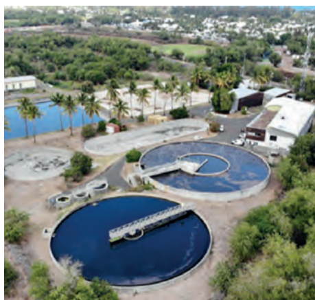
Station de traitement d'eaux usées
