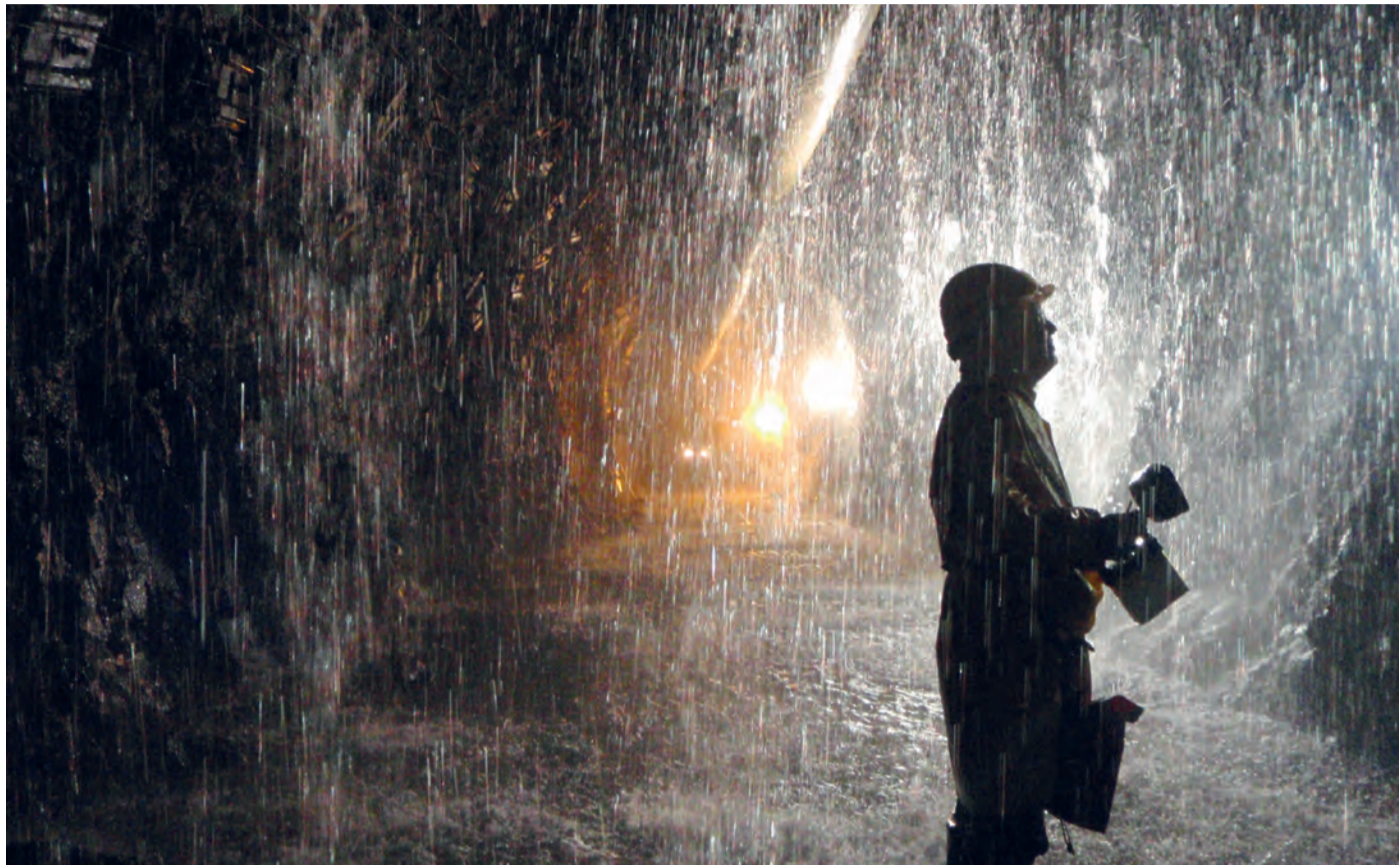
Chantier titanesque étalée sur plusieurs décennies, le projet ILO compte plus de 30 kilomètres de galeries souterraines qui traversent les cirques de Salazie et Mafate.
