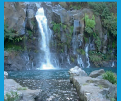
Captage d'eau de surface (Ravine St Gilles)
