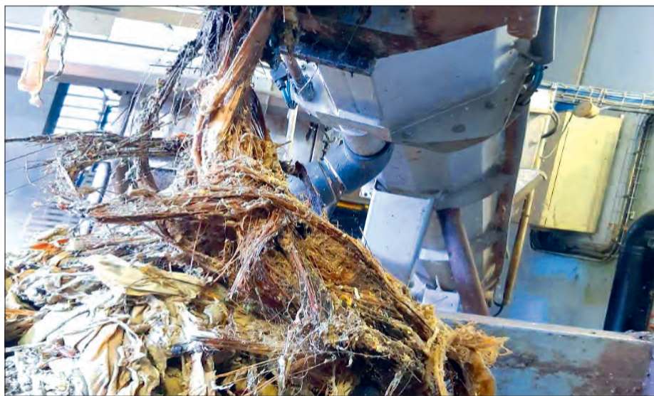
Ici des déchets recueillis sur le dégrilleur du poste de refoulement de la Jamaïque. (lingettes, serviettes, chiffons et même une branche de palmiers).
