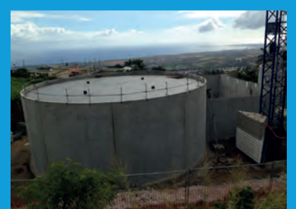
Création d'un nouveau réservoir
