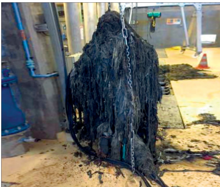
Près de 200 kilos de déchets filandreux qui recouvrent une pompe sur 1,5 mètre de hauteur. L'accumulation des déchets rejetés dans le réseau provoque des pannes sur les pompes.
