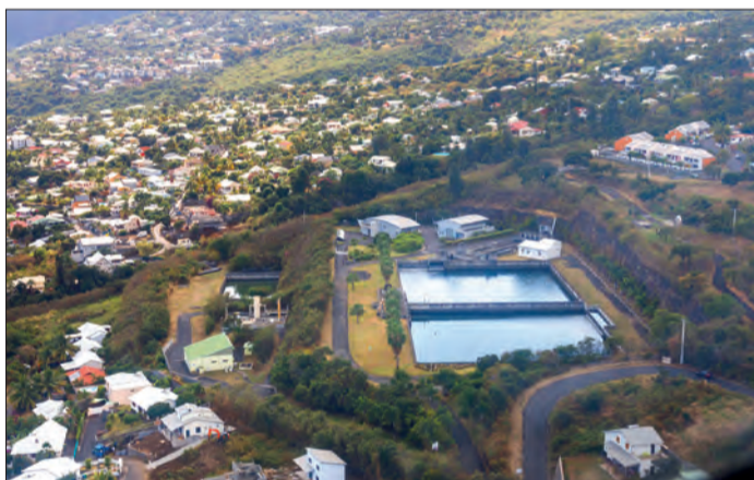
Le projet Ilo a permis de sécuriser la distribution d'eau pour tous les usages. Ici le réservoir de Mon Repos à la plaine Saint-Paul, d'une capacité de 50 000 m 3 .
