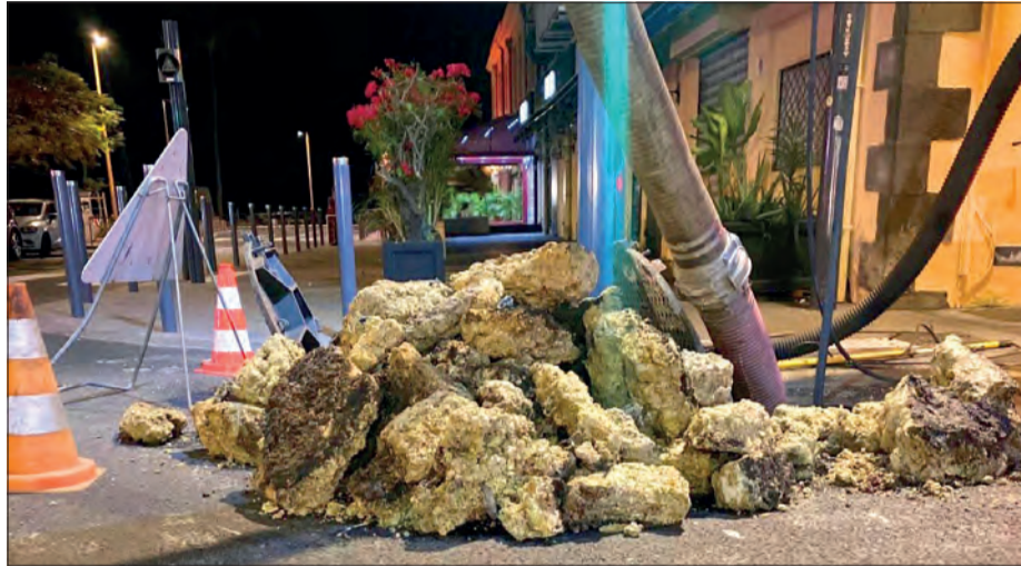
Ici des blocs de graisse retirés du réseau d'assainissement au cours d'une opération sur le réseau en juillet 2022, sur la rue de Nice à Saint-Denis.
